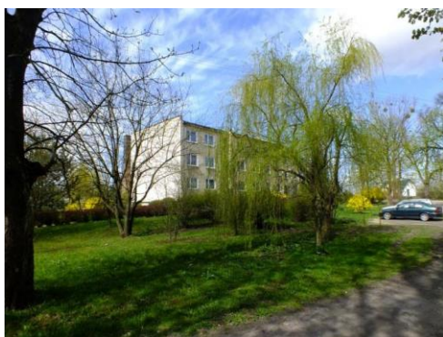
Fot. 2. Blok mieszkalny w Niezabitowie
